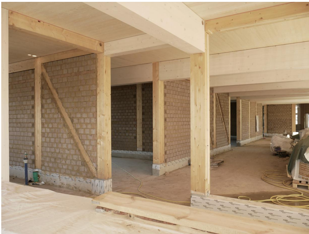
Bild 1: Die tragende Holzkonstruktion wurde mit 24 cm Lehmsteinmauerwerk ausgefacht. Final werden die Wände mit Lehm verputzt.
